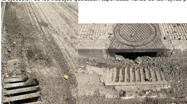
C/Méjico, retirada de asfalto.
