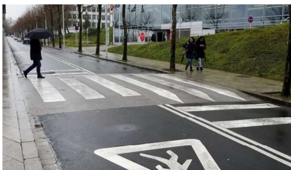
Ilustración 14. Paso de peatones elevado en las proximidades de un colegio en Santiago de Compostela.
