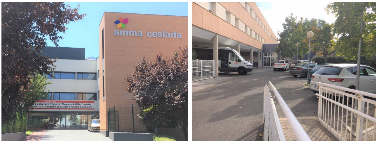
Fotografías de los accesos a las residencias Amavir (AMMA Coslada) y DOMUSVI. Asociación Jubilares
