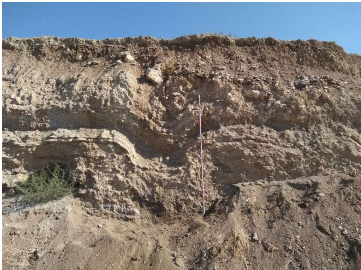
Detalle de la zona donde se ha documentado la deformación de los niveles cuaternarios por hundimiento-colapso kárstico del sustrato yesífero infrayacente
