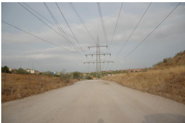
Línea de alta tensión en la zona meridional del ámbito.
