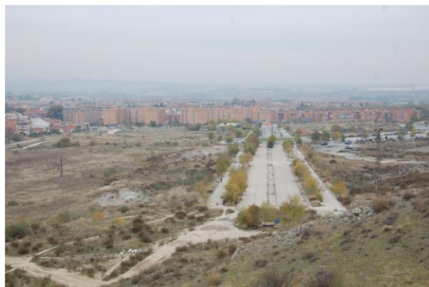
Vista panorámica de las líneas de media tensión en la zona suroeste del ámbito.
