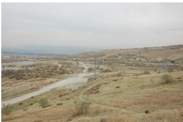
Vista panorámica de la línea de media tensión más oriental.
