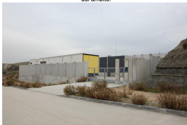
Entrada a la subestación eléctrica situada al sur del ámbito.
